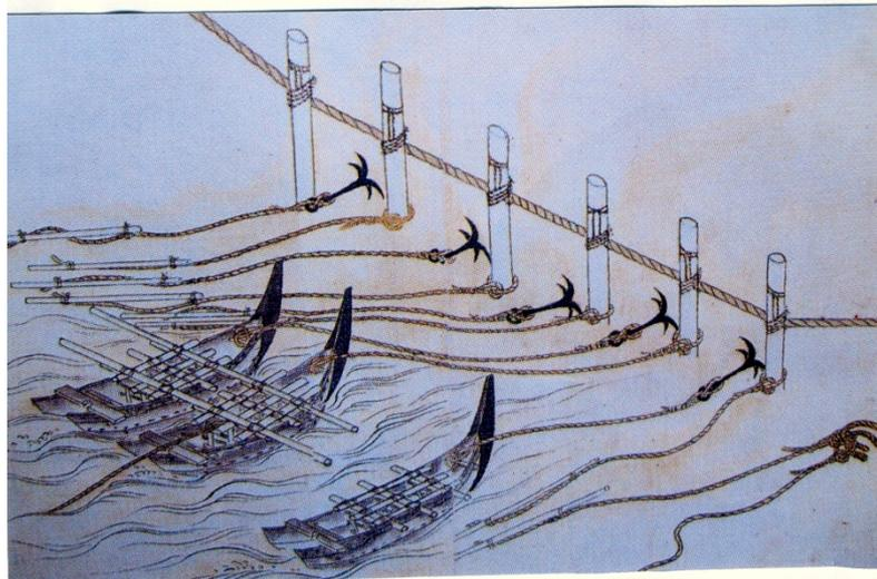
図 2・9・34 馬入川舟橋絵図〔東幸-7〕「馬入川船橋絵図・敷舟施工図」
